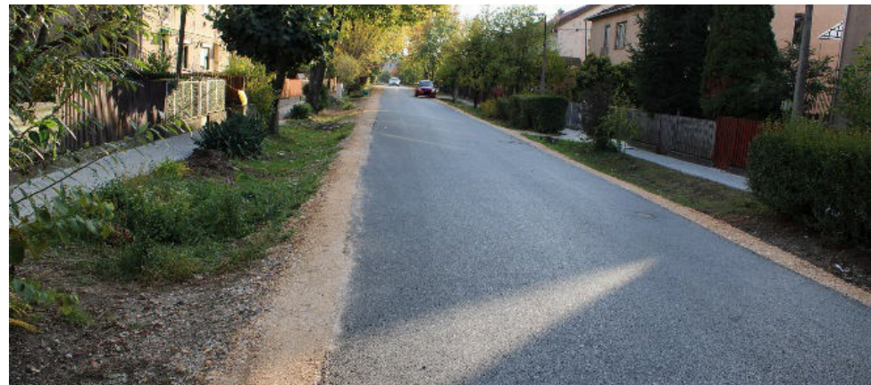
ÚTBURKOLAT FELÚJÍTÁS A BÁNYÁSZ UTCÁBAN
