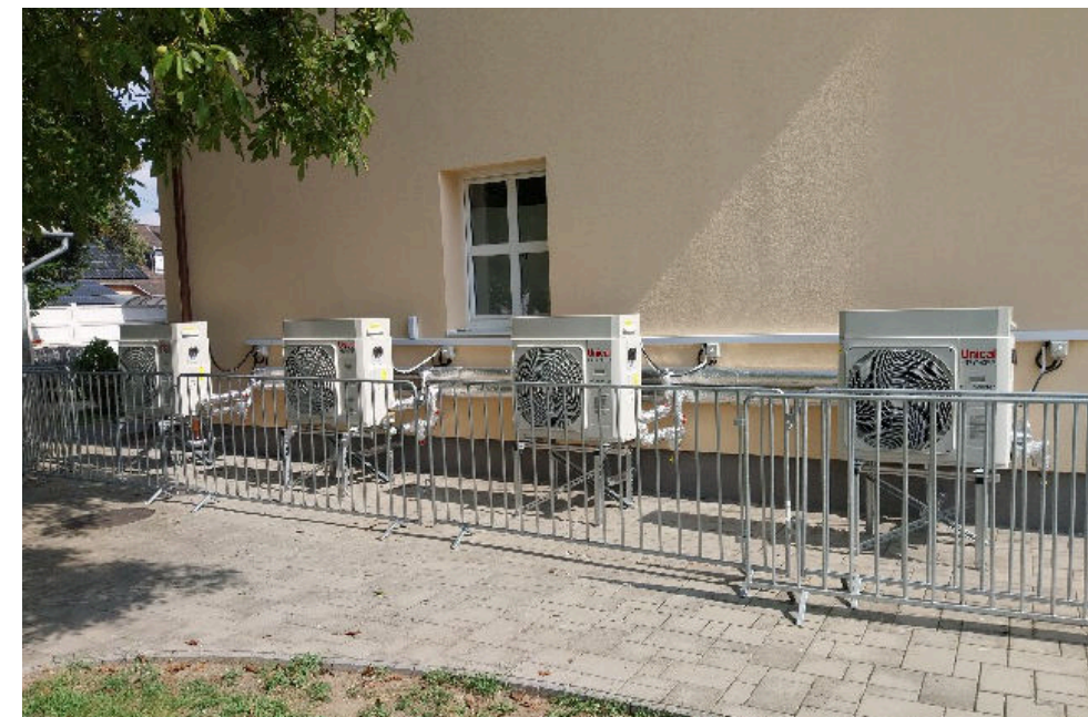
A PÉCSI SÁNDOR MŰVELŐDÉSI HÁZAT IS HIBRID HŐSZIVATTYÚ – KONDENZÁCIÓS KAZÁN RENDSZER FŰTI
