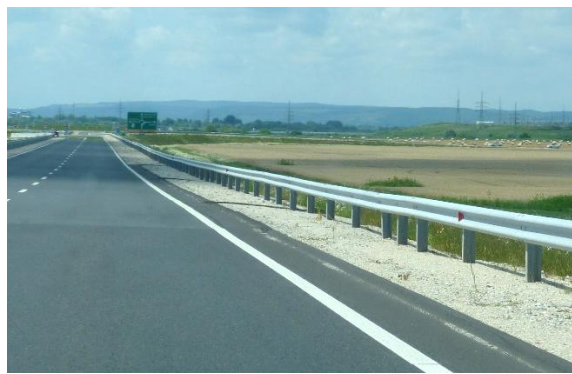
A 260-as másodrendű főút, aminek a jobb oldalán fog húzódni a 400 kV-os távvezeték keresztezve a 27-es másodrendű főutat. Háttérben a 27-es és 260-as utak körforgalmú kereszteződése.
