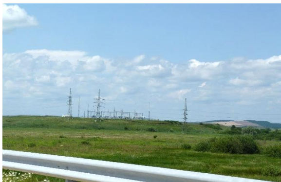
Előtérben a 260-as másodrendű főút, ami mellett fog futni a tervezett 400 kV-os távvezeték. A háttérben a meglévő 132 kV-os távvezeték, illetve a Telkes Mária Naperőmű berendezései.
