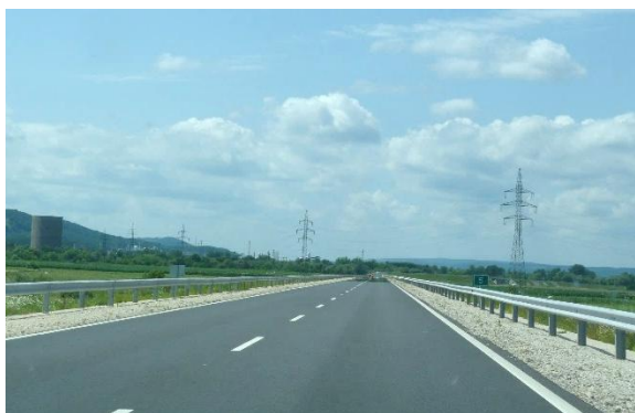
Sajószentpéter nyugati kapujában a meglévő 132 kV-os távvezeték keresztezi a 260-as másodrendű főutat. Az út jobb oldalán fog a tervezett 400 kV-os távvezeték futni.
