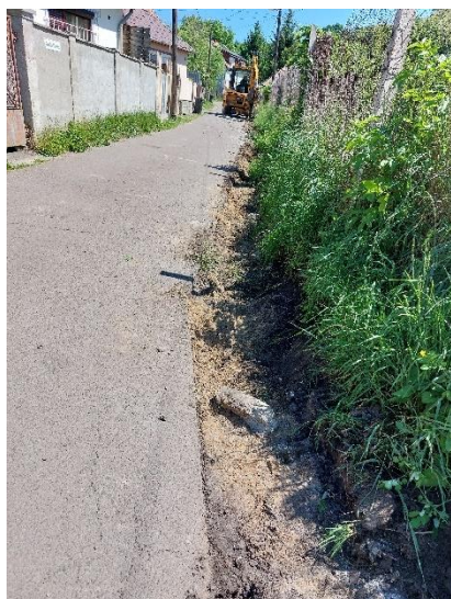
Benedek Elek köz vízelvezető folyóka karbantartása (hagyományos közmunkaprogram)
